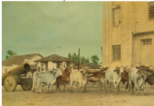
Figura 7: Construção da Igreja Matriz de Heitorai (déc. 1950)
